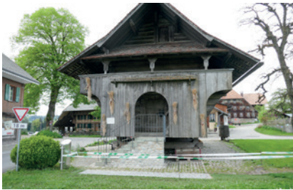
Die 130 Pflastersteine vor dem Dorfspycher wurden verlegt. Bilder: zvg
